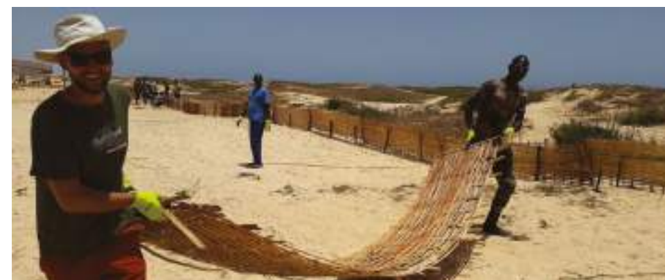
Installation de panneaux de protection à Yeumbeul Nord avant le reboisement du Littoral Nord, 2019
