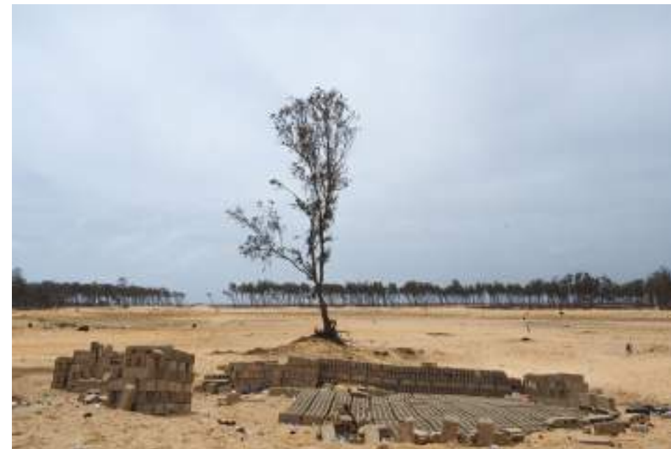
Construction en dure sur la bande de filaos à Ndiarème Limamoulaye, 2018
