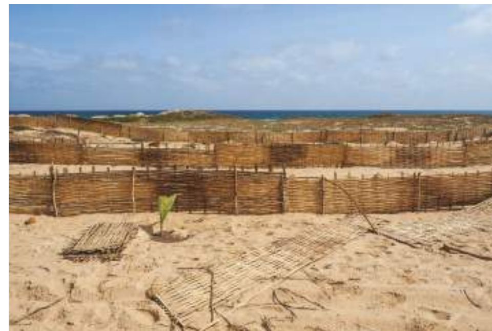
Installation de panneaux de protection dans les parcelles reboisées à Sam Notaire, 2019
